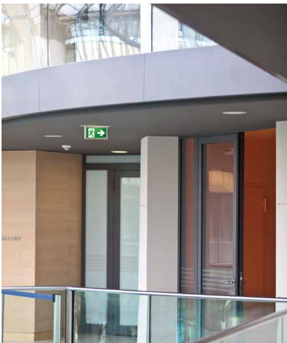
Bild 1: Rettungszeichen gemäß DIN ISO 7010 mit Richtungspfeil rechts. Die Pfeilrichtung kann je nach Fluchtrichtung unterschiedlich sein.
