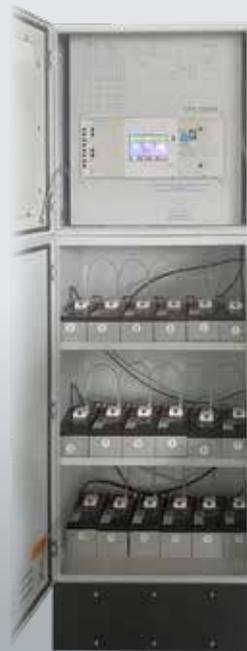
Abb. 7: Gruppenbatterieanlage mit einer Batteriespannung von 216 V (Reihenschaltung von 16 Stück verschlossener 12 V Batterien)
