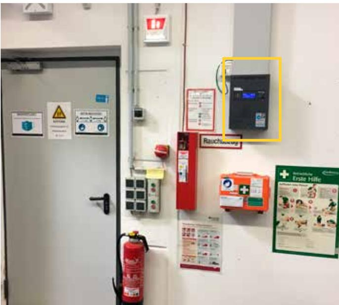
Abb. 3: Dieses LPS-System versorgt ca. zehn Leuchten der Sicherheitsbeleuchtung in einer Fertigungshalle, die als separater Sicherheitsbeleuchtungsabschnitt gilt. Das LPS-System enthält zwei verschlossene Batterien à 12 V / 7,2 Ah.
