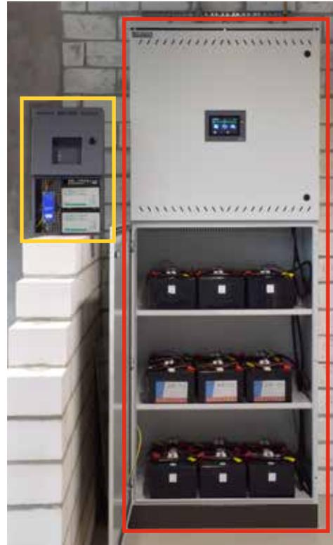
Abb. 5: Ein aktuelles CPS-System als zentrale Batterieanlage (rote Markierung) und ein LPS-System für dezentrale Anwendung (gelbe Markierung) mit jeweils verschlossenen Batterien
