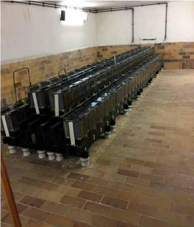
Abb. 4: Geschlossene Batterien einer Zentralbatterieanlage aus den 70er-Jahren (Darstellung ohne Ladestation)
