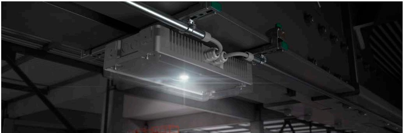
Das robuste pulverbeschichtete Aluminiumdruckgussgehäuse der SN 8500 ist bestens für den Einsatz in der Industrie geeignet. Durch die hohe Schutzart IP65 ist die Leuchte gegen das Eindringen von Wasser und Staub geschützt.
